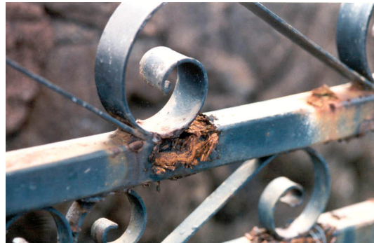
Figura 8.6 – Exemplo de corrosão em frestas
